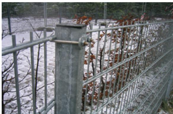
Zaunpfosten - glatt ohne Bohrungen inkl. Abdeckkappe. U-Bügel bestehend aus rostfreiem Edelstahl 1.4301 und feuerverzinkter Gegenplatte mit Muttern.
